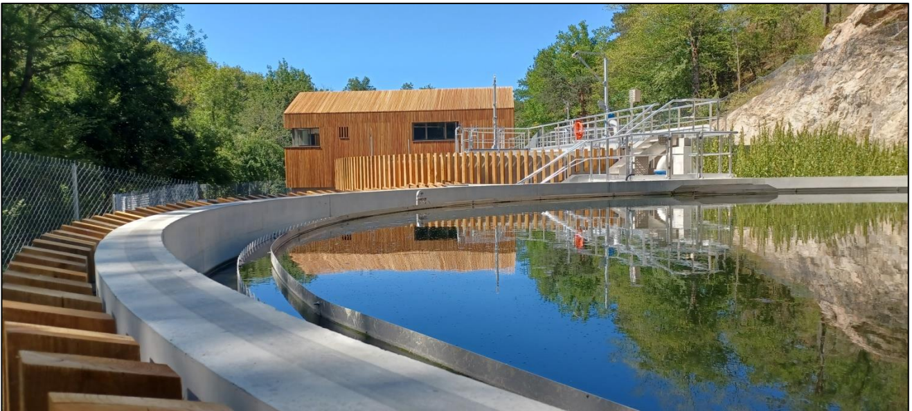
Station d'épuration Saint-Victor-sur-Loire – Les Tourettes
